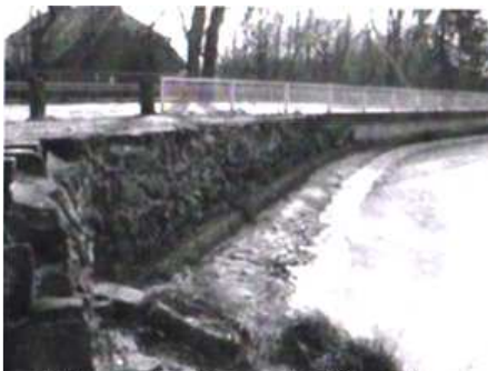
Teil vom alten Damm des Seeweiher
